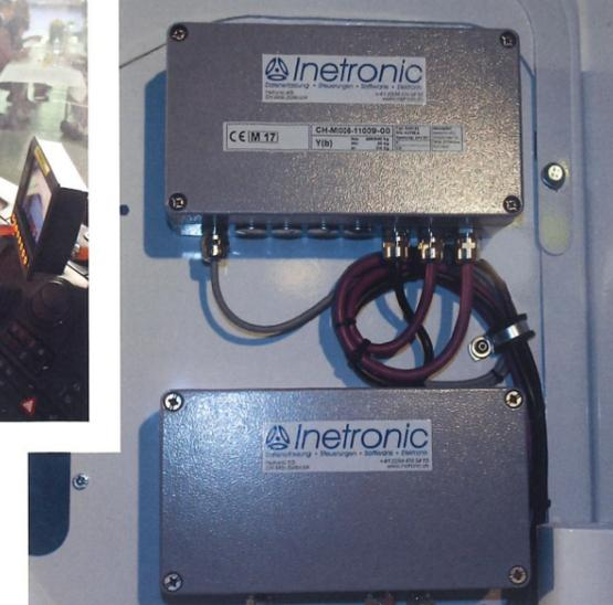
Die elektronische Waage von Inetronic erfasst den Besitzer des Containers sowie das Gewicht des Inhalts.
